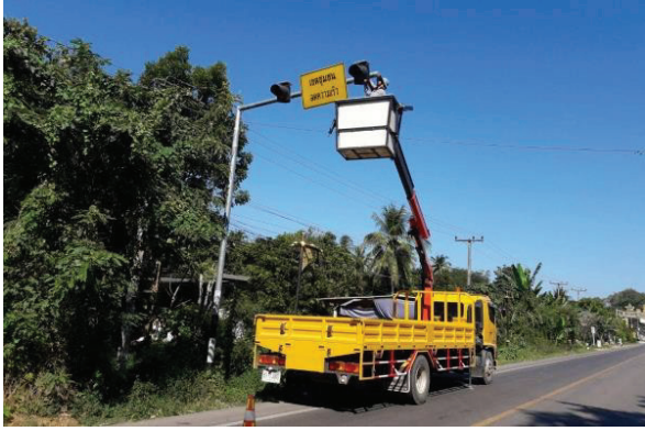
รูปที่ 2.18 การปรับปรุงสัญญาณไฟกระพริบและสัญญาณไฟจราจร
