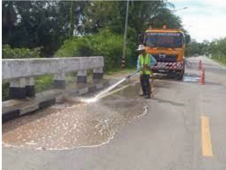
รูปที่ 1.10 การทำความสะอาดผิวจราจร
