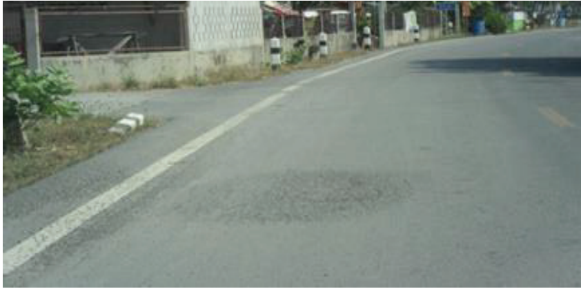
รูปที่ 3.8 ลักษณะความเสียหายของผิวทางลาดยาง ประเภททรุดตัวเป็นแอ่ง
