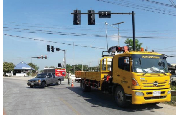
รูปที่ 2.18 การปรับปรุงสัญญาณไฟกระพริบและสัญญาณไฟจราจร
