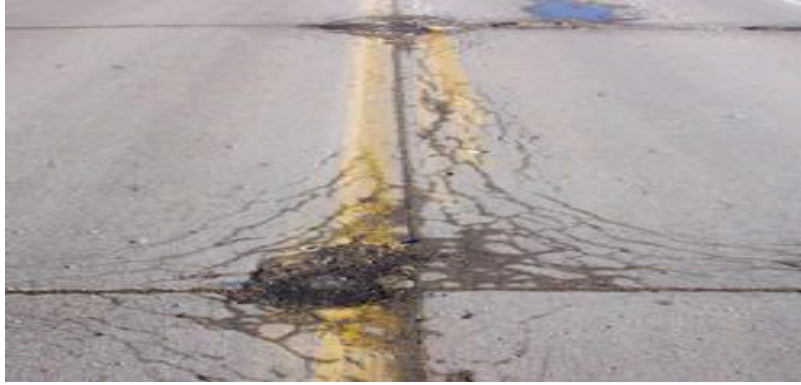
รูปที่ 3.19 ลักษณะความเสียหายของผิวทางคอนกรีต ประเภทรอยแตกจากความคงทนของวัสดุ
