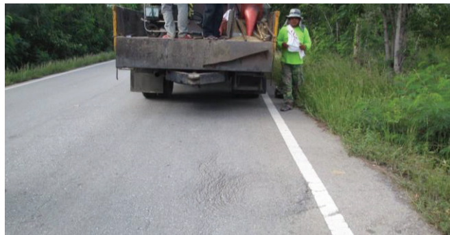
รูปที่ 3.5 ลักษณะความเสียหายของผิวทางลาดยาง ประเภทรอยแตกจากการหดตัว
