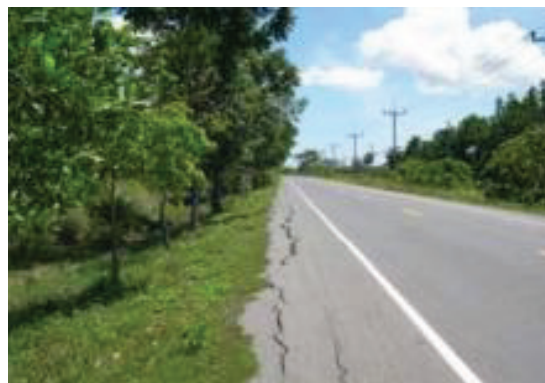
รูปที่ 3.7 ลักษณะความเสียหายของผิวทางลาดยาง ประเภทรอยแตกขอบผิวทางและตามยาว
