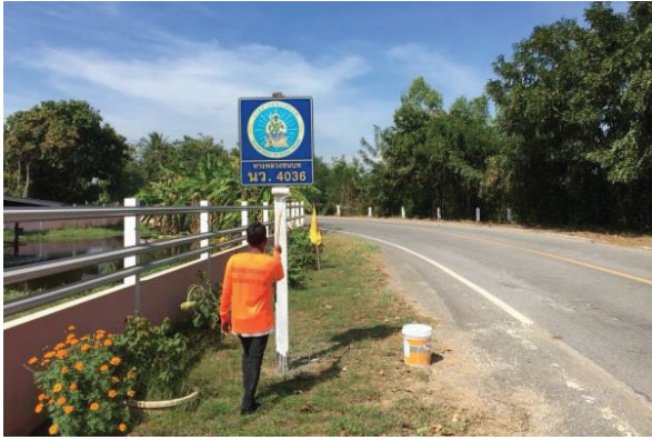
รูปที่ 2.16 ทาสีและทดแทนป้ายจราจรเดิมที่ชำรุด
