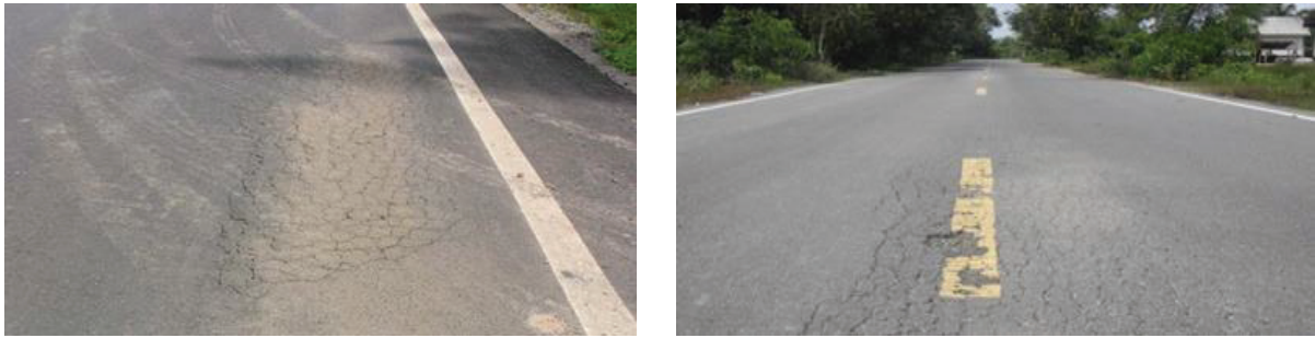
รูปที่ 3.4 ลักษณะความเสียหายของผิวทางลาดยาง ประเภทรอยแตกแบบหนังจระเข้
