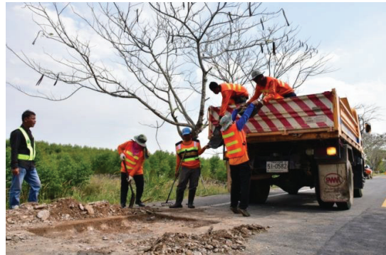
รูปที่ 2.6 ขุดตามพื้นที่ที่จะทำการซ่อมและขนวัสดุเดิมที่เสียหายขนทิ้ง
