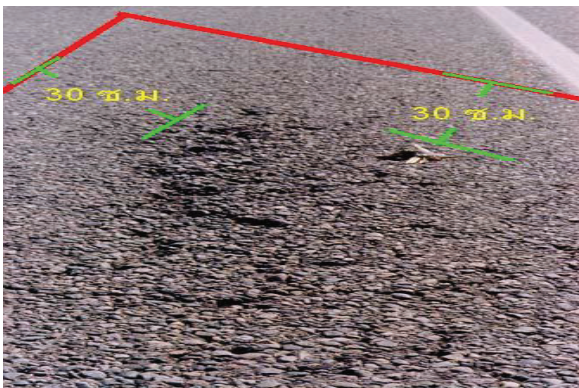
รูปที่ 4.4 ลักษณะความเสียหายแบบผิวทางหลุดร่อนและรูปแบบการวัดพื้นที่ความเสียหาย
