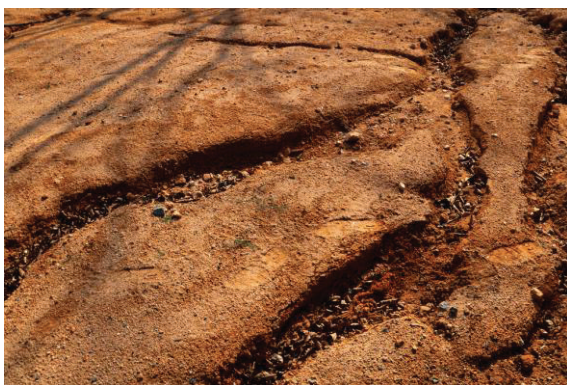
รูปที่ 1.1 การกร่อนแบบริ้วบริเวณผิวถนน (Rill erosion)
