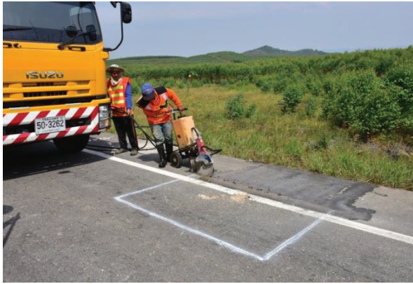
รูปที่ 2.4 ตัดขอบตามพื้นที่ ๆ จะทำการปะซ่อม
