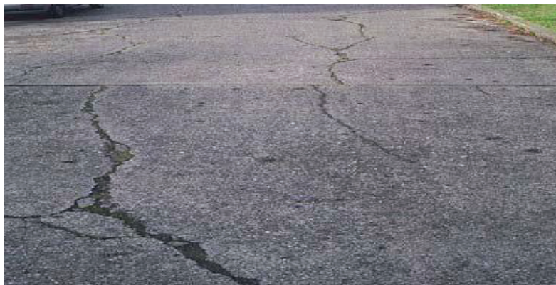
รูปที่ 3.22 ลักษณะความเสียหายของผิวทางคอนกรีต ประเภทรอยแตกตามแนวยาว
