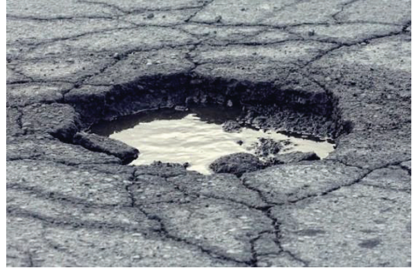
รูปที่ 3.12 ลักษณะความเสียหายของผิวทางลาดยาง ประเภทหลุมบ่อ
