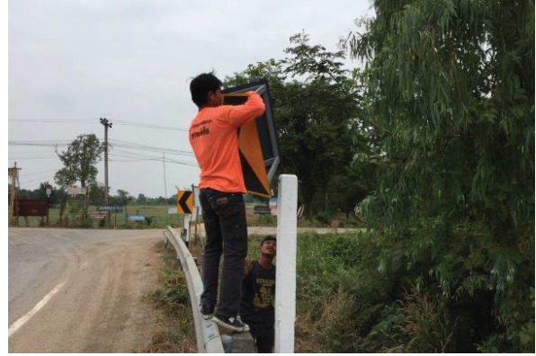
รูปที่ 2.16 ทาสีและทดแทนป้ายจราจรเดิมที่ชำรุด
