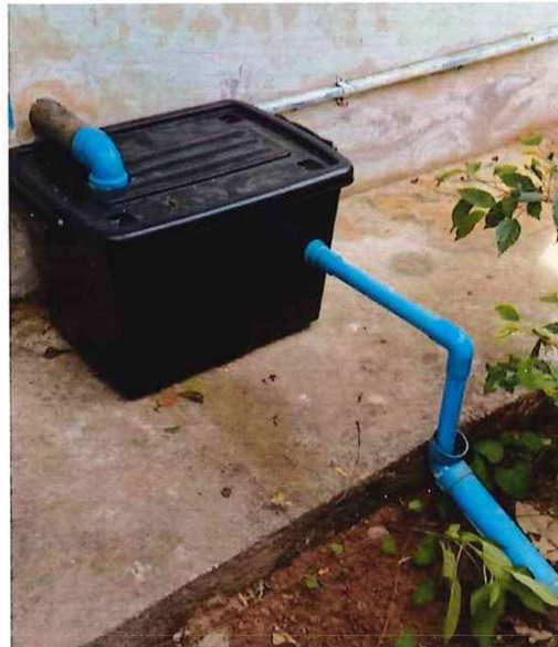
ภาพถังดักไขมัน ศูนย์พัฒนาเด็กเล็กตำบลท่าเรือ
