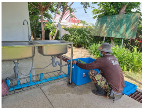
๓. ภาพการดำเนินการติดตั้งบ่อตกไขมันขององค์กรปกครองส่วนท้องถิ่น
