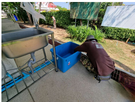
๓. ภาพการดำเนินการติดตั้งบ่อตกไขมันขององค์กรปกครองส่วนท้องถิ่น
