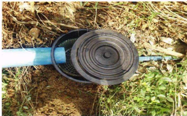
๓.ภาพการดำเนินการติดตั้งบ่อดักไขมันขององค์การบริหารส่วนตำบลภูคา
